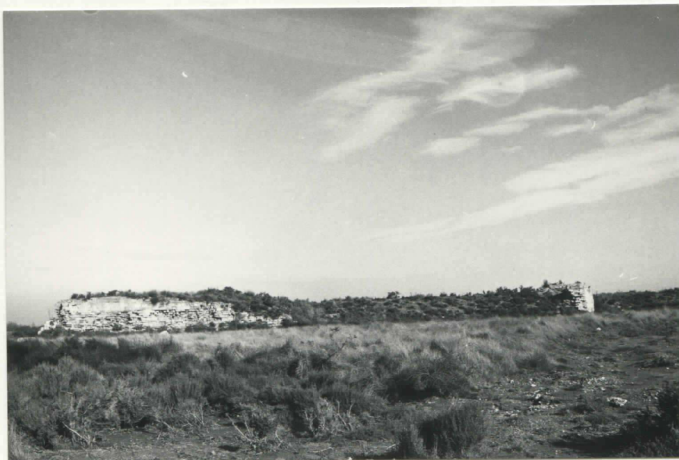
Courtine Ouest effondrée
